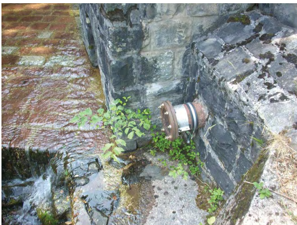
VISTA 10 – TUBAZIONE SCARICO DI FONDO ACQUE DE22
