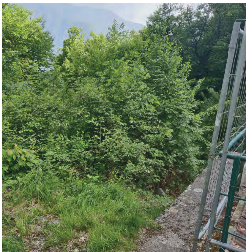
VISTA 4 - SCARPATA LATERALE ADIACENTE ALL'ORGANO DI PRESA
