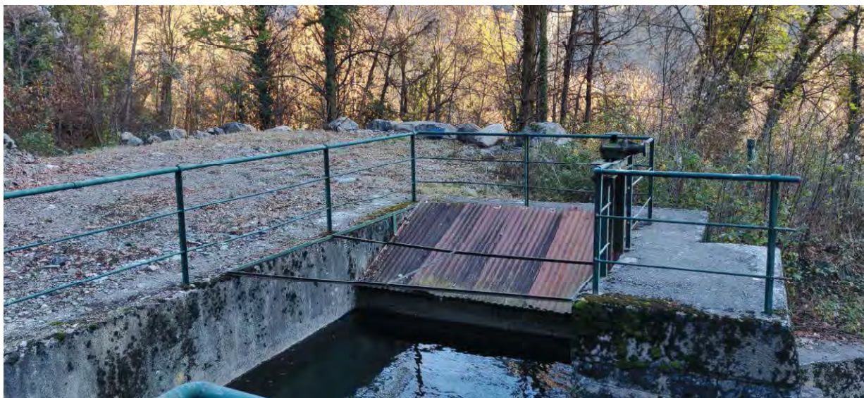
VISTA 5 – VASCA ACCUMOLO ACQUE ESISTENTE CON PARATOIA DI REGOLAZIONE, TETTOIA E GRIGLIA PER FILTRAGGIO ACQUE
